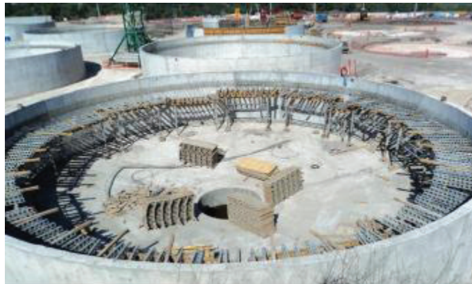
Fotografía 1. Se aprecia la cimbra en el canal del espesador de gravedad
