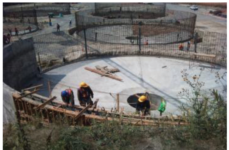
Fotografía 3. Se observa la cimbra metálica que es utilizada para colar los muros del tanque.
