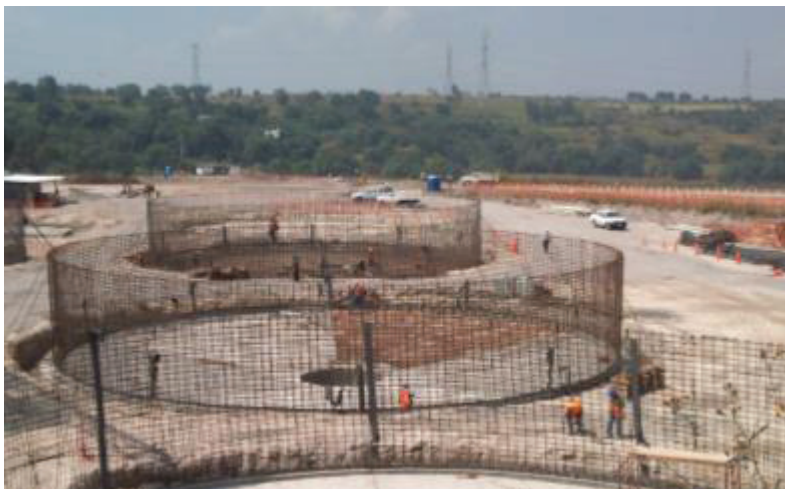
Fotografía 2. En esta imagen se puede apreciar el armado del acero de refuerzo del cilindro del tanque espesador
