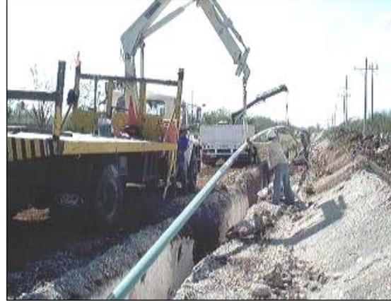
Cuando se descargue tubo sobre el DDV (franja de afectación), se colocará sobre apoyos adecuados de costales rellenos de arena o polines de madera.
