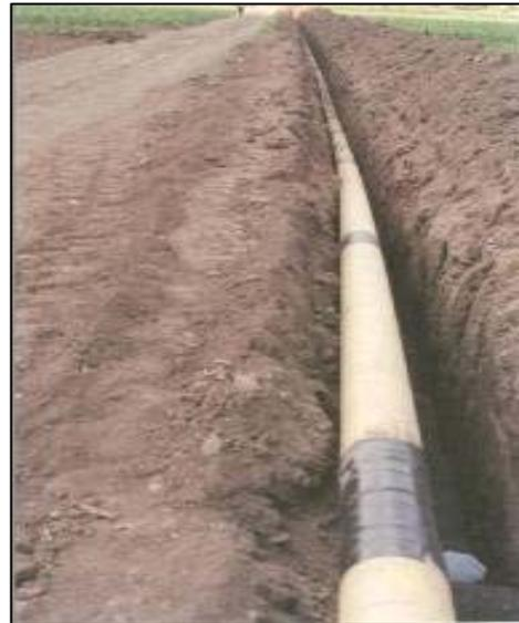
**Descenso de la tubería.-** Después de que el ducto se haya soldado, la tubería será bajada a la zanja usando maquinaria especializada tipo pluma. Se usarán fajas anchas no abrasivas para bajar la tubería a la zanja, dependiendo de la extensión del tramo y del terreno. Se colocará en su lugar con suficiente holgura para evitar compresiones en la línea en caso de que hubiera asentamientos.
