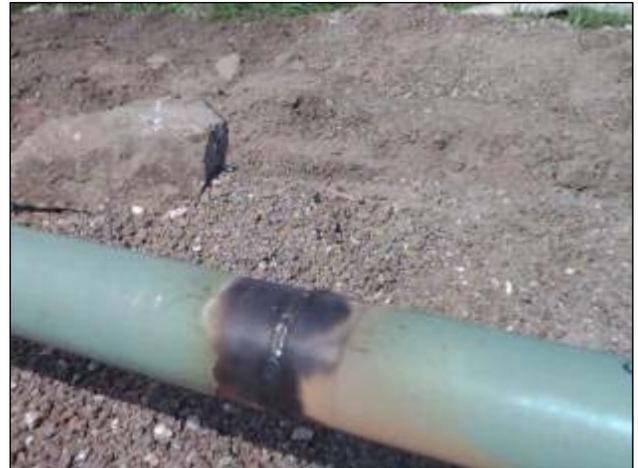
Toda la soldadura en tubería de acero se llevará a cabo utilizando un procedimiento de soldadura calificado y soldadores calificados.
