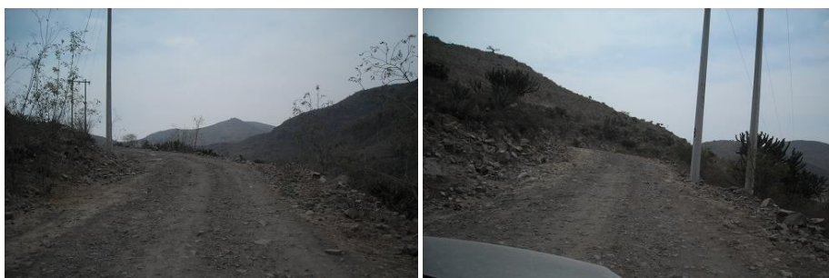
Superficie de rodamiento y líneas de CFE
