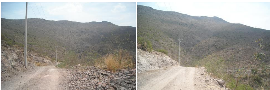
Sobre el trazo de terracería existente
