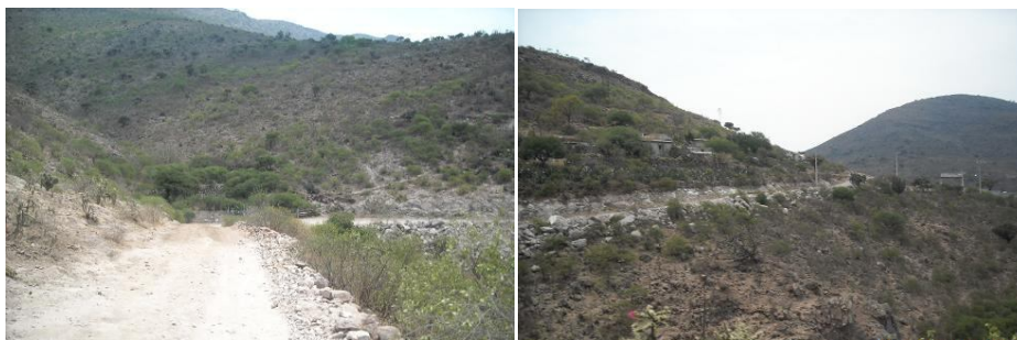
Vista del camino aproximadamente al km 1+100 siguiendo el trazo.
