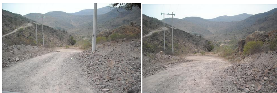
Se puede apreciar a la par del camino la línea eléctrica
