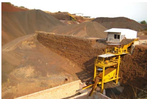
Planta trituradora de agregados pétreos, banco El Bermejo, ubicado en el Cerro Colorado, municipio de Huichapan.
