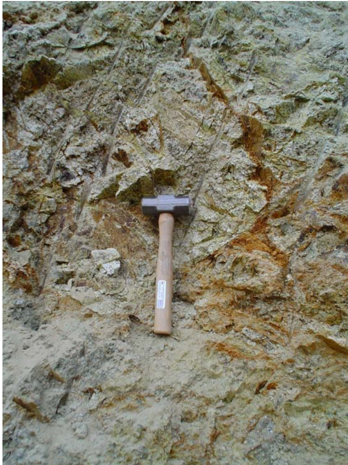
Foto 4. Vista del Intrusivo Humbolt, sobre la carretera.
