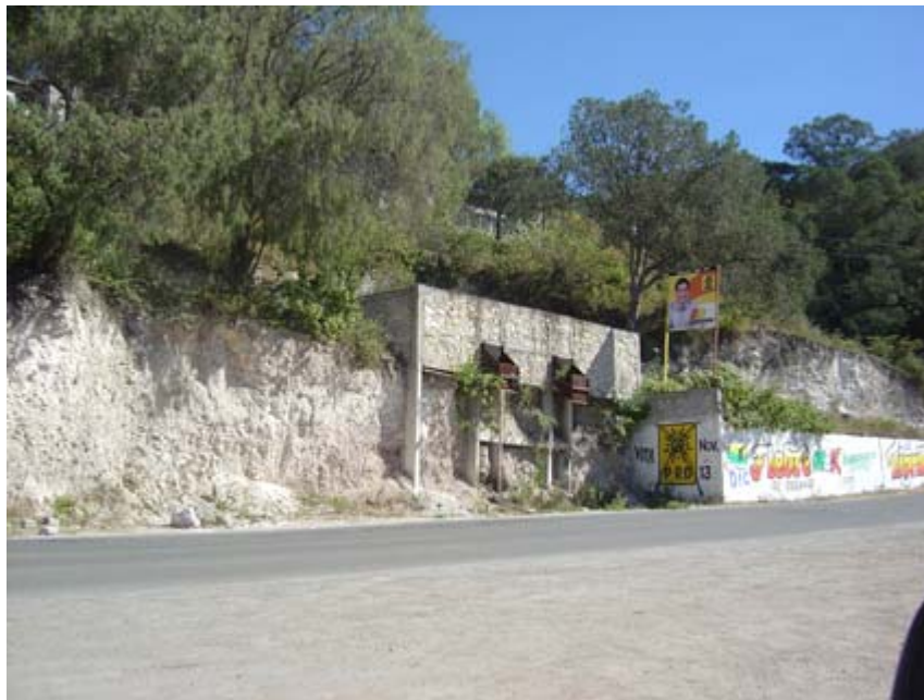
Foto 7.- Vista de las Tolvas en el Socavón Cortés.
