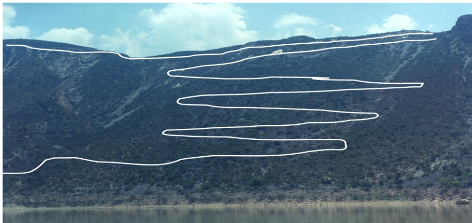
Figura 3.4. Camino de acceso
