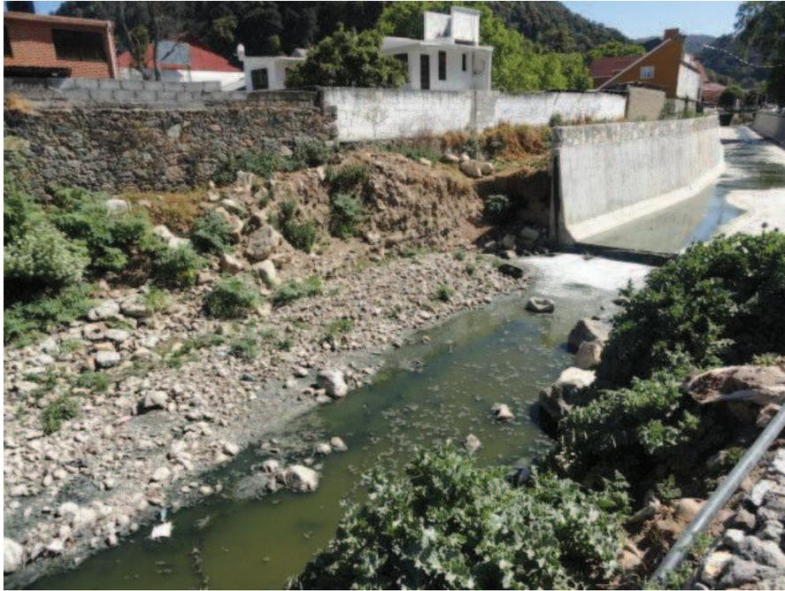
*Imagen 4 Vista del revestimiento del dren pluvial sobre el río el Manzano en la cabecera municipal.*
