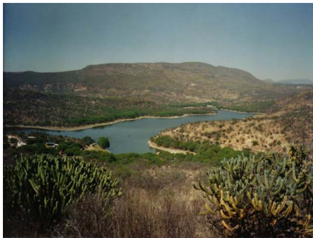
Figura No. 3 Presa derivadora Paso de Tablas (2006).
