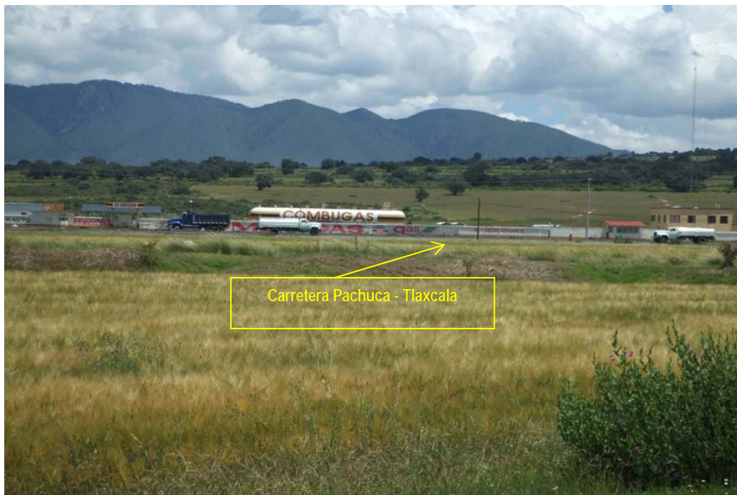
Foto 4. Al nor-este y norte el límite del predio colinda con la carretera Pachuca – Tlaxcala.
