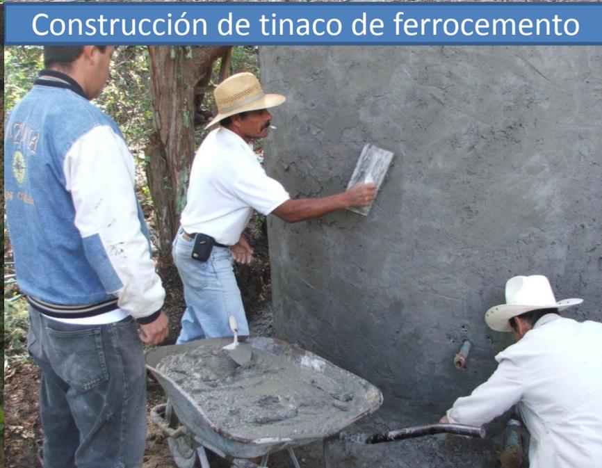
Construcción de tinaco de ferrocemento
