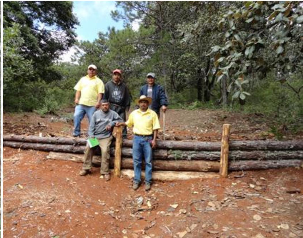
Con la construcción de presas de morillos se están estabilizando 2 cárcavas, la primera de 980 metros y la segunda de 650 metros de longitud en el paraje “Los Ángeles”.
