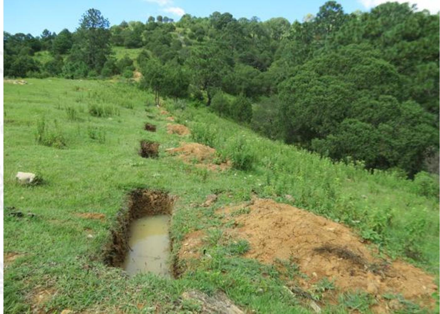
Con la construcción de 15,600 m de zanjas trinchera, se logra captar 2,496 m<sup>3</sup> de agua por lluvia cuando se llenan en su totalidad
